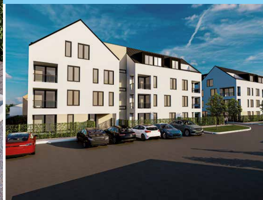
SBD SEVER STAVÍ DRUŽSTEVNÍ BYTY V CHLUMCI | 2
