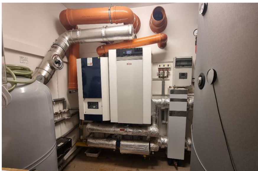
Kotelna Na Pískovně 647
