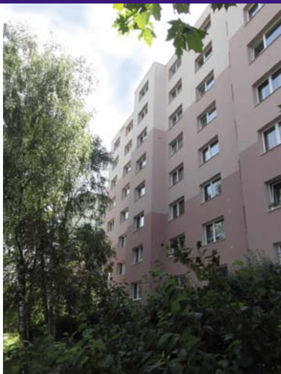
V rámci dotačního programu IPRM se zatepluje i panelový dům na sídlišti Rochlice
