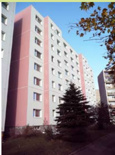
Zateplit dům se rozhodlo také nově vzniklé společen- ství ve správě SBD Sever v ul. Mšenská v Jablonci nad Nisou.
