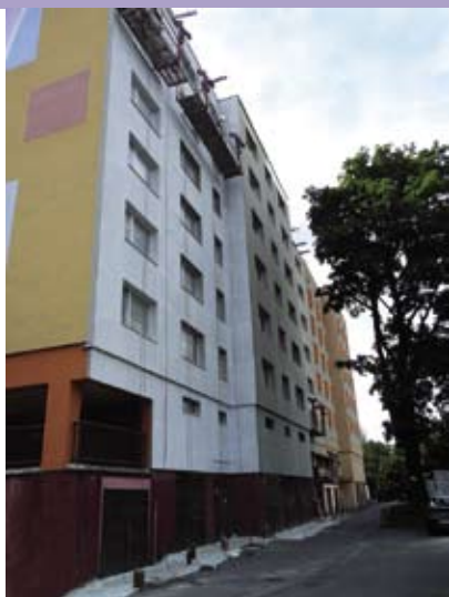
Práce jsou v plném proudu. Na snímku dům v ul. Žitná.
