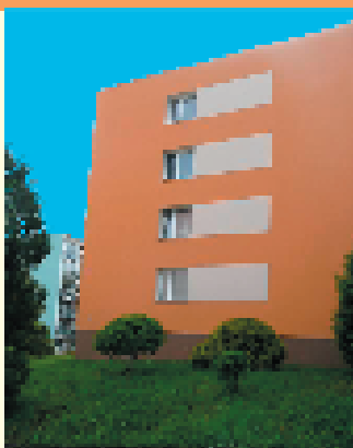
Zateplení štítové stěny domu v ulici Žitná v rámci dotačního programu EU IPRM Rochlice
