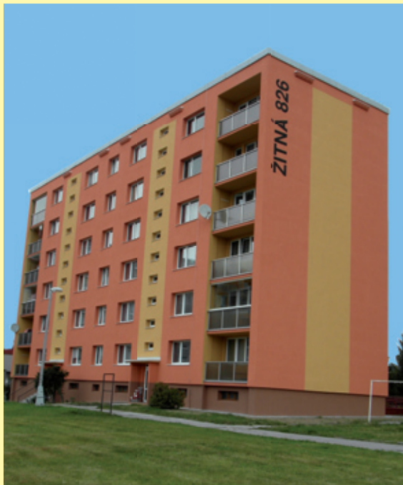
Rekonstruovaný a zateplený dům v Žitné ulici
