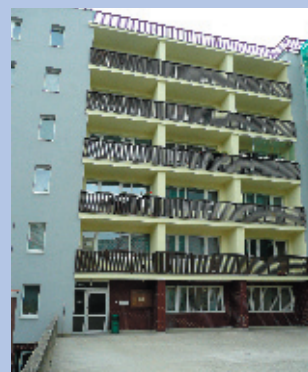
Součástí prací byla též sanace ložní včetně výměny zábradlí. Stavební práce provedla liberecká stavební společnost Fireo.
