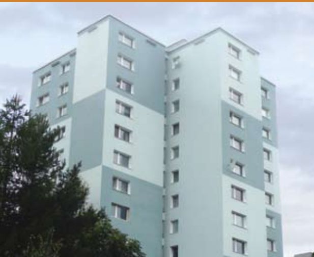
Dům v ulici Sametová byl rekonstruován a zateplen v letošním roce s použitím vysoce kvalitních bezcementových omítek.
