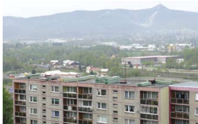
Rekonstrukce a nástavba střechy na domě Žitná 827-828
