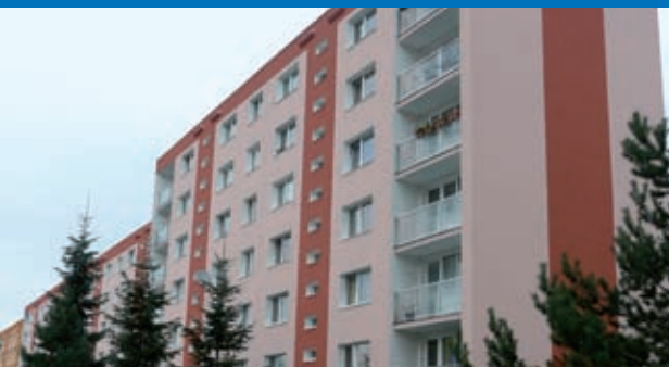
V loňském roce byla s podporou programu Zelená úsporám provedena rekonstrukce a zateplení několika domů ve Sněhurčině ulici.
