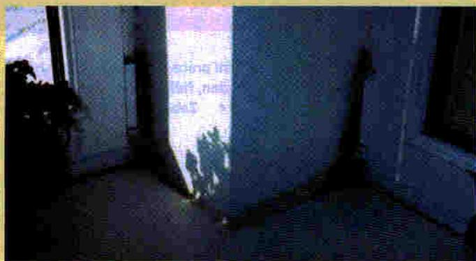
Bežný okenní rám přisazený k venkovnímu ozubu bez přerušení tepelného mostu a absence difuzní uzávěry způsobily totální zhodnocení připojovací spáry.
