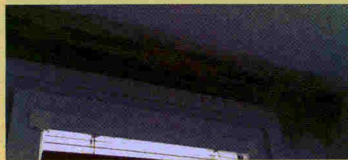
Zapomenutý ocelový osazovací rám starého okna v nadpraží a výměna vzduchu pouze přes „mikroventilaci“ extrémně ochlazuje nadpraží okna
