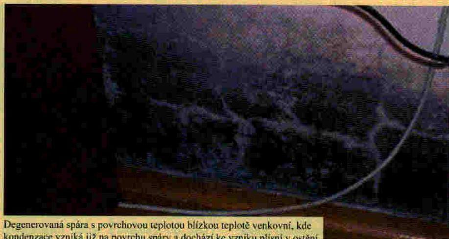
Degenerovaná spára s povrchovou teplotou blízkou teplotě venkovní, kde kondenzace vzniká již na povrchu spáry a dochází ke vzniku plísní v ostění.
