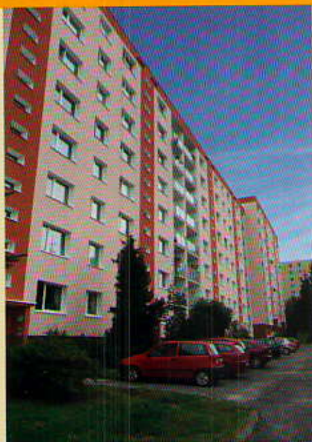
V roce 2010 družstvo zateplilo a rekonstruovalo soubor panelových domů ve Sněhurčíně ulici s využitím dotačního programu Zelená úsporám.
