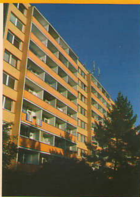
Panelový bytový dům v ulici Březová alej prošel v minulých letech sanací včetně zateplení.
